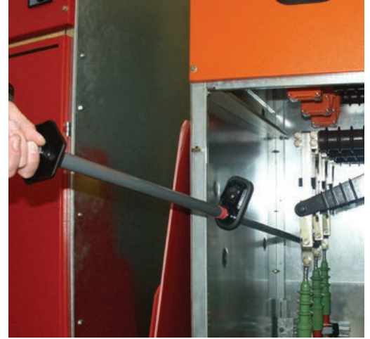
Jännitteenkoetin PHG II käytössä tyyppitestatussa kojeistossa.
