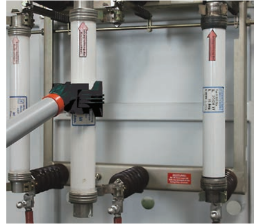
Sulakkeiden vaihto 20° käännetyllä tartuntakynnellä.
