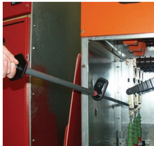
Jännitteenkoetin PHG II käytössä tyyppitestatussa kojeistossa.
