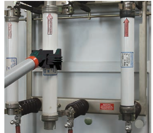
Sulakkeiden vaihto 20° käännetyllä tartuntakynnellä.
